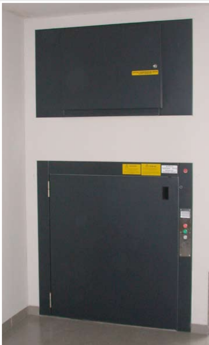
...obere Haltestelle mit Triebwerksraum
