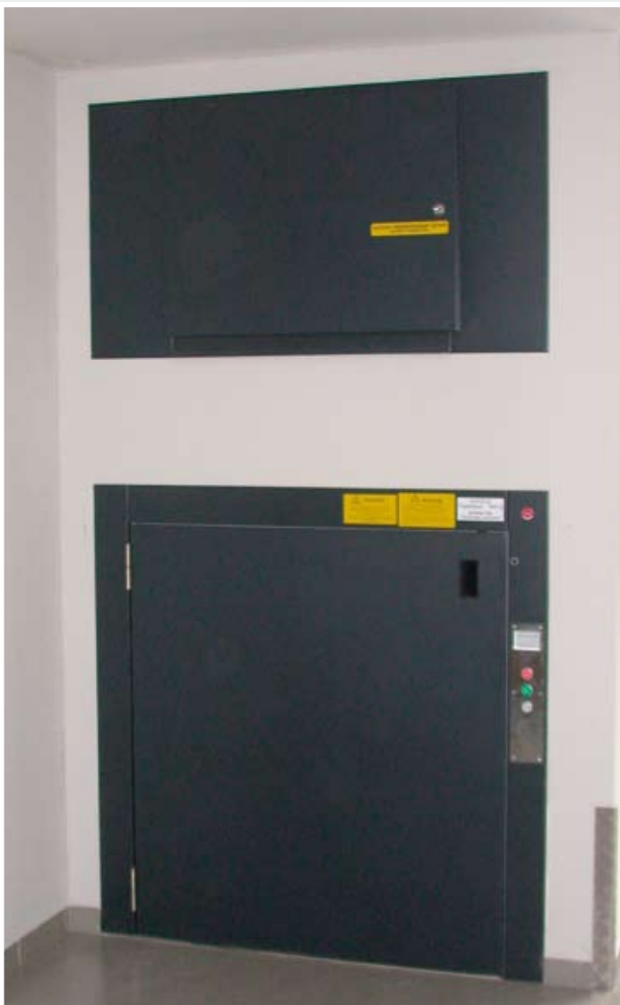
...Cargo-Boy obere Haltestelle mit Triebwerksraum
