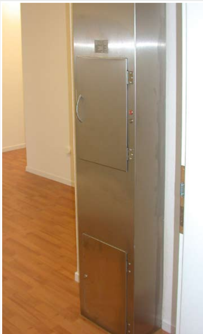
...Labor-Boy Haltestelle unten mit Triebwerksraum
